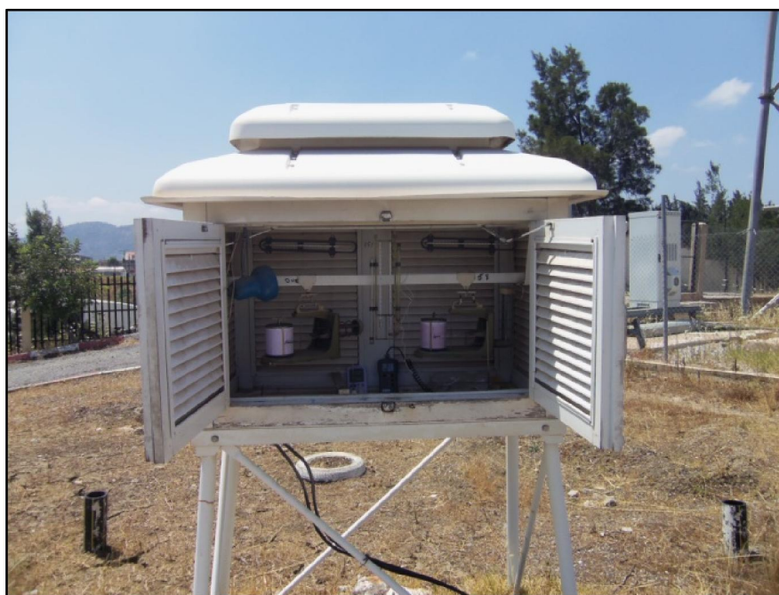
Figure IV.25 : Vue sur l'abri contenant les instruments de mesures.
