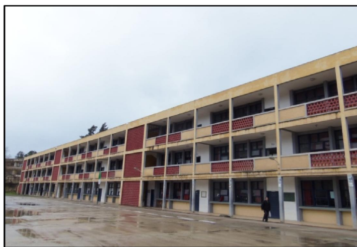
Figure. IV.9 : photo du lycée Stambouli Rabah.
